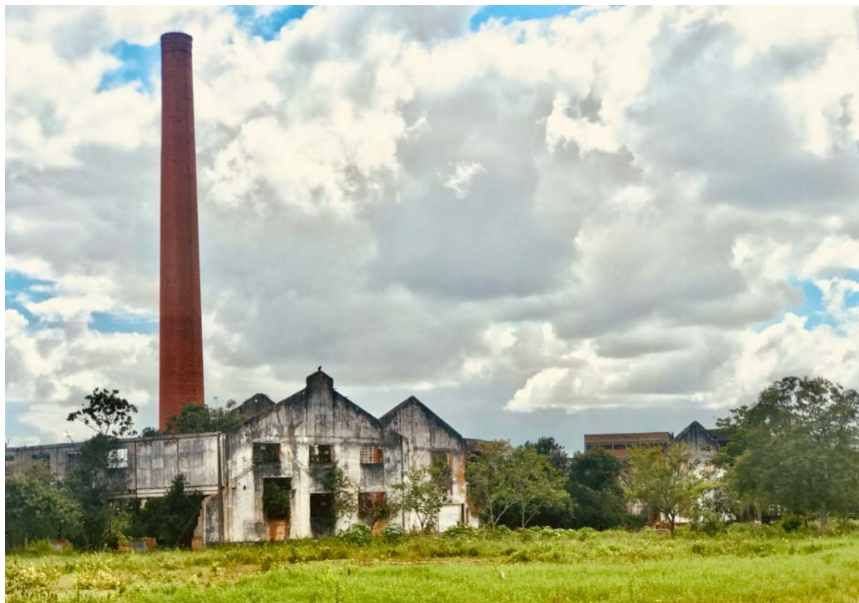
Imagem 47. Ruínas da falida usina São João, Campos dos Goytacazes (RJ). Fotografia.
